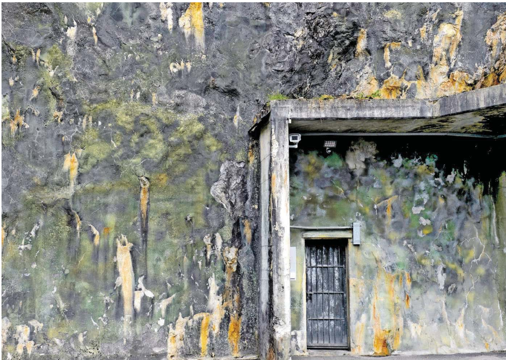
Der Kalte Krieg ist längst vorbei, heute wird um Daten gekämpft. Der getarnte Eingang zum Datacenter in einem ehemaligen Militärbunker.
